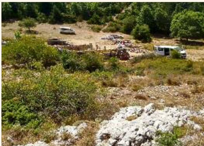
Vue générale du chantier
