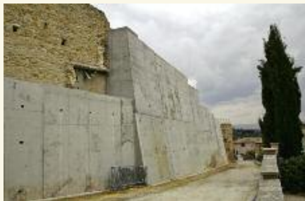
Les remparts en béton seront recouverts d'un habillage en vieilles pierres
